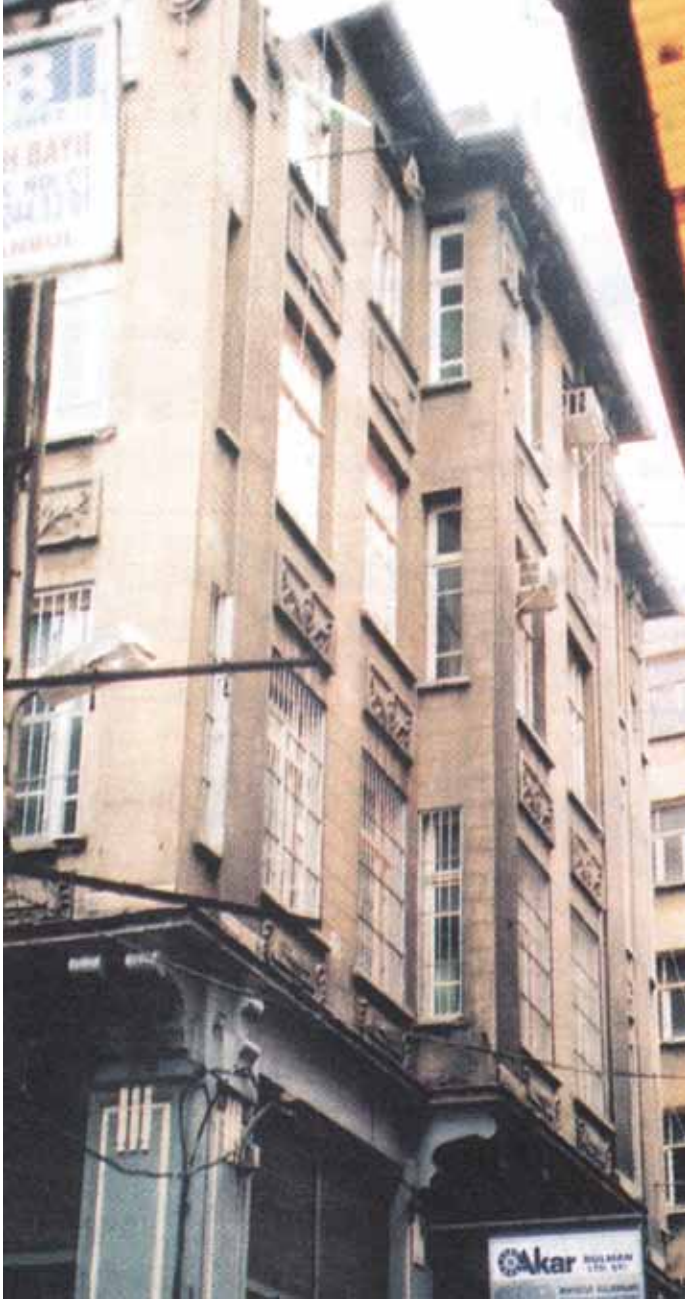
KARAKÖY - ÇEŞME SOKAĞI'NDA, DİNDES AİLESİ TARAFINDAN İNŞA ETTİRİLEN VE ŞU AN SURP PIRGIÇ HASTANESİ'NİN TAPULU MÜLKÜ OLAN ROMAN HAN
