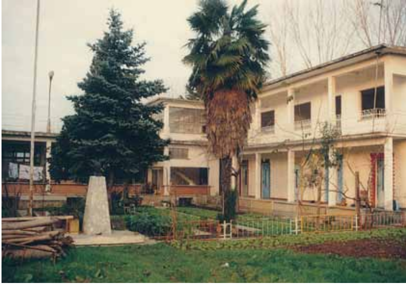
ÖN CEPHE FRONT FAÇADE
