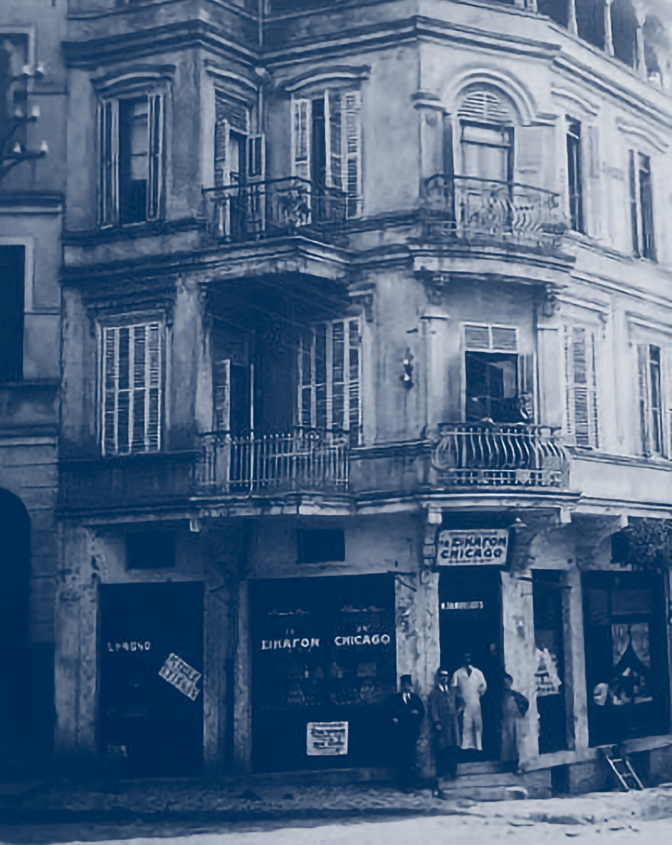
İstanbul Şişli'de tabela ve vitrinlerinde Ermenice, Rumca, Osmanlıca, İngilizce, Fransızca yazılar bulunan, M. Samuelides'in Şikago Bakkaliyesi. (Calumeno Ailesi Koleksiyon ve Arşivi)
