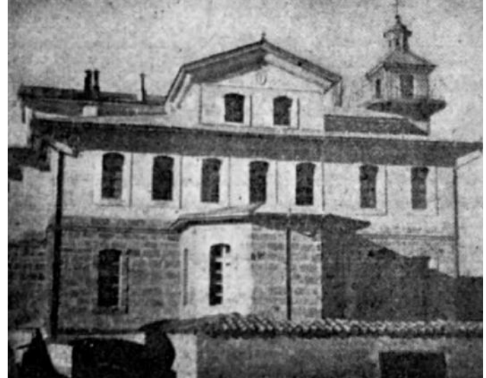
Cezvit Kilisesi ve okul binası
