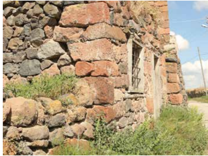
Tomarza, Cücün Köyü. Ermeni yapılarının taşları yeniden kullanılmış Village of Cücün, Tomarza. The stones from Armenian buildings were reused in newer constructions
