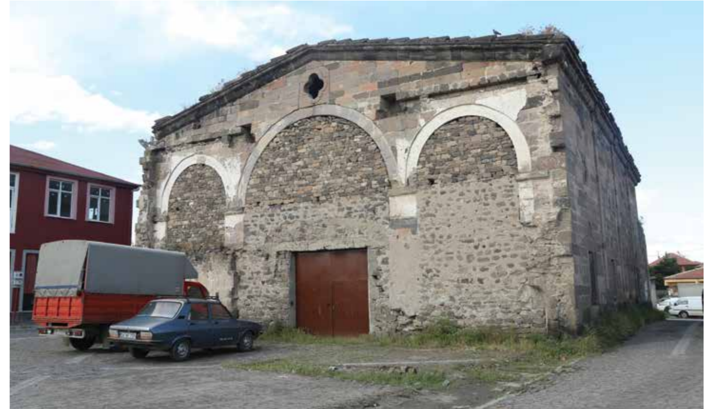
Tomarza'daki Surp Boğos Bedros Kilisesi
